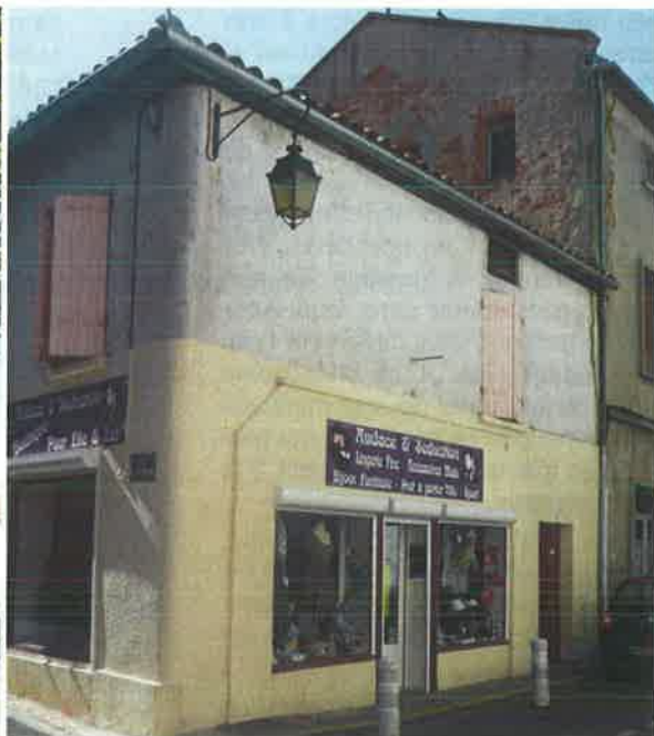
Ouvertures de baies dénaturant la façade, «croutage» au ciment, coffres en saillie.
