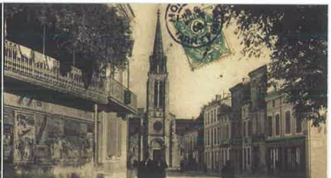
Boulevard Alsace-Lorraine. 1864 Reconstruction de l'église Saint Jacques entre le boulevard créé en 1808 et le canal 1847. La cicatrisation de ce secteur qui n'est ni un boulevard, ni une place n'a jamais été réellement réglée . 2 Fi Moissac 47. A.D.T.G.
