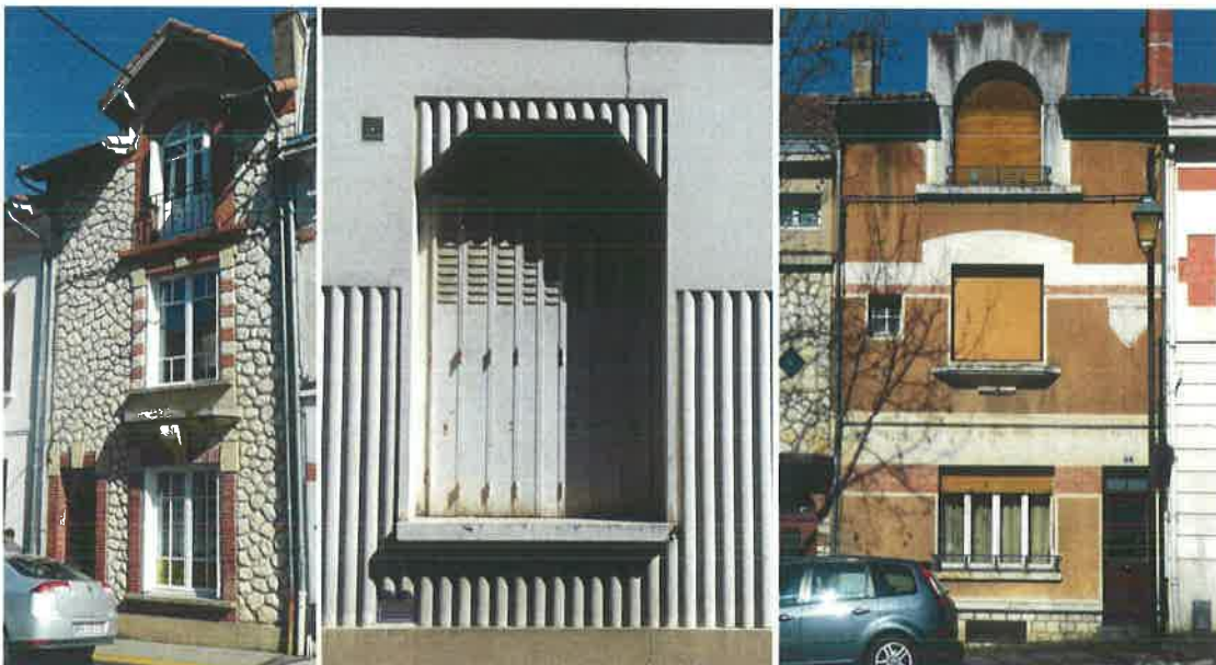
Décor de briques, appareil incertum fausses pierres. Décor tubulaire, ciment, rue Gal Gras. Soubassement faux appareil de pierres, décor brique et enduit peint, rue Cayrou.
