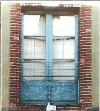
Fenêtre type XIX e . Partition des croisillons et petits bois à grands carreaux. La fenêtre était équipée de contrevents à l'origine comme en témoigne la feuillure de l'encadrement.
