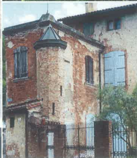
Rue de l'Abbaye, vestiges médiévaux. Maison Vidal.
