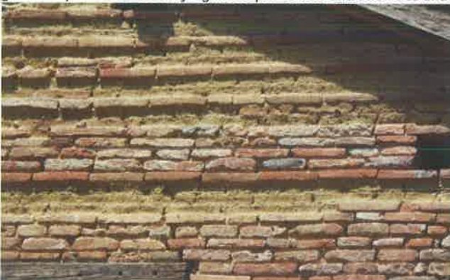
Lits de briques d'adobe et de briques de terre cuite alternés.
