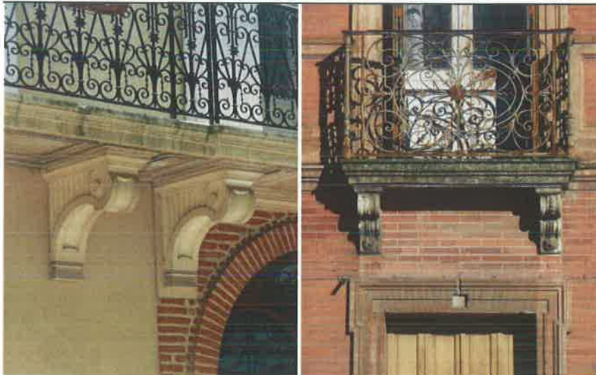
Détails d'architecture , Balcons allées Marengo et bd. de Brienne.
