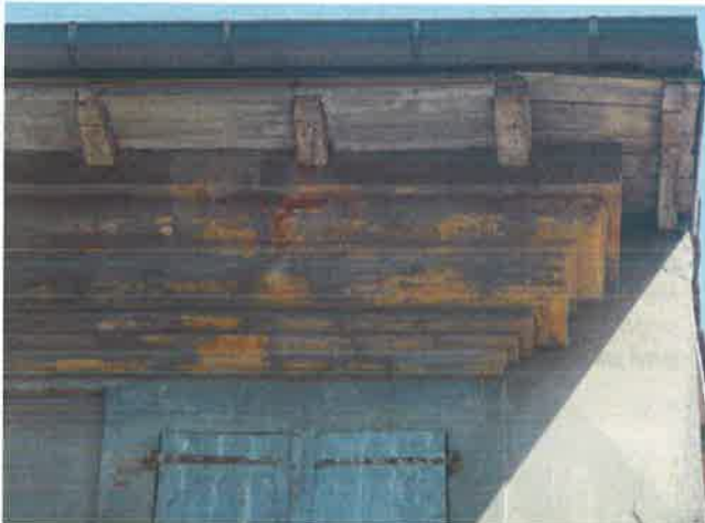
Corniche et passe de toit en coffre de planches.
