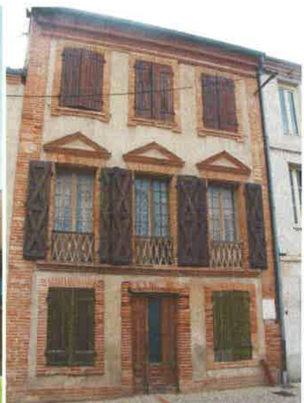
Rue Marcusus. Encadrements et modénature en briques, maçonnerie enduites et badigeon coloré.
