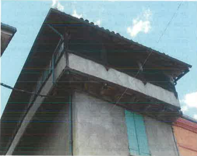
Mirande. Angle des rues Malavielle et Dérua.
