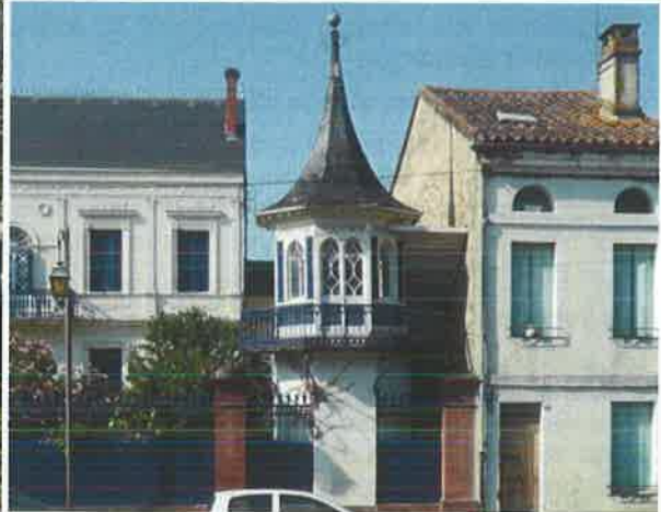
Quai Magenta, ouvrage remarquables : kiosque éclectique, clôture avec piliers de briques, grilles en fer forgé et panneaux métalliques montés sur mur bahut.
