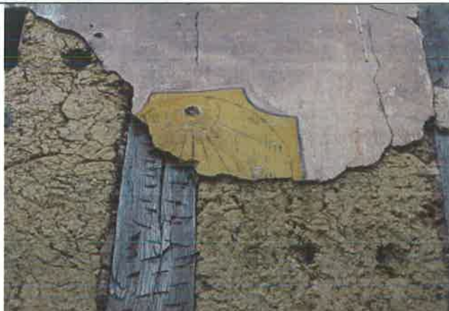
Pans de bois et torchis dégradé et vestiges d'enduit de protection à la chaux sur torchis. Ces maçonneries anciennes présentent de grandes qualités mais sont fragilisées par le non entretien des enduits.
