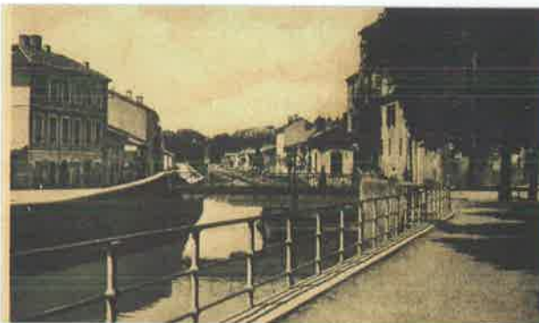
La cicatrisation urbaine sur la percée du canal a été réussie grâce à la qualité des ouvrages, à la cohérence des alignements bâtis et des gabarits et aux plantations ordonnées.
