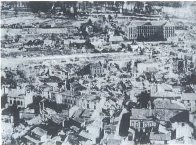
Moissac dévastée après la grande crue de 1930.
