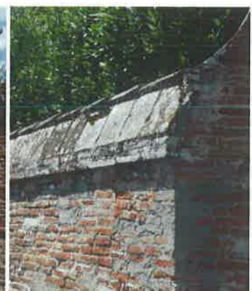
Mur de clôture ancien rue Raynal. Détail du couronnement.
