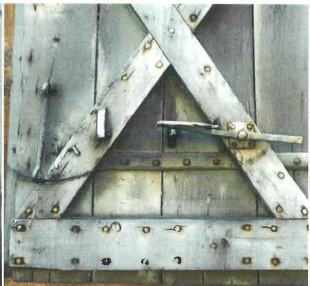
XVIII e détail de ferronnerie, système de clôture des contrevents.
