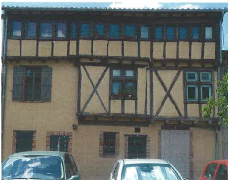
Maison à pans de bois. Place du Trésor. Le rez-de-chaussée est établi en briques maçonnées (encadrement des portes et fenêtres en briques) ; premier étage en encorbellement et pans de bois percé de larges croisées ; second étage : mirande en pans de bois et encorbellement. La maçonnerie est protégée par un enduit à la chaux.
