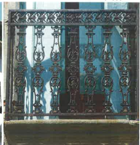
Rue Gambetta. Garde corps fonte. Architecture éclectique et éléments de décor manufacturés.
