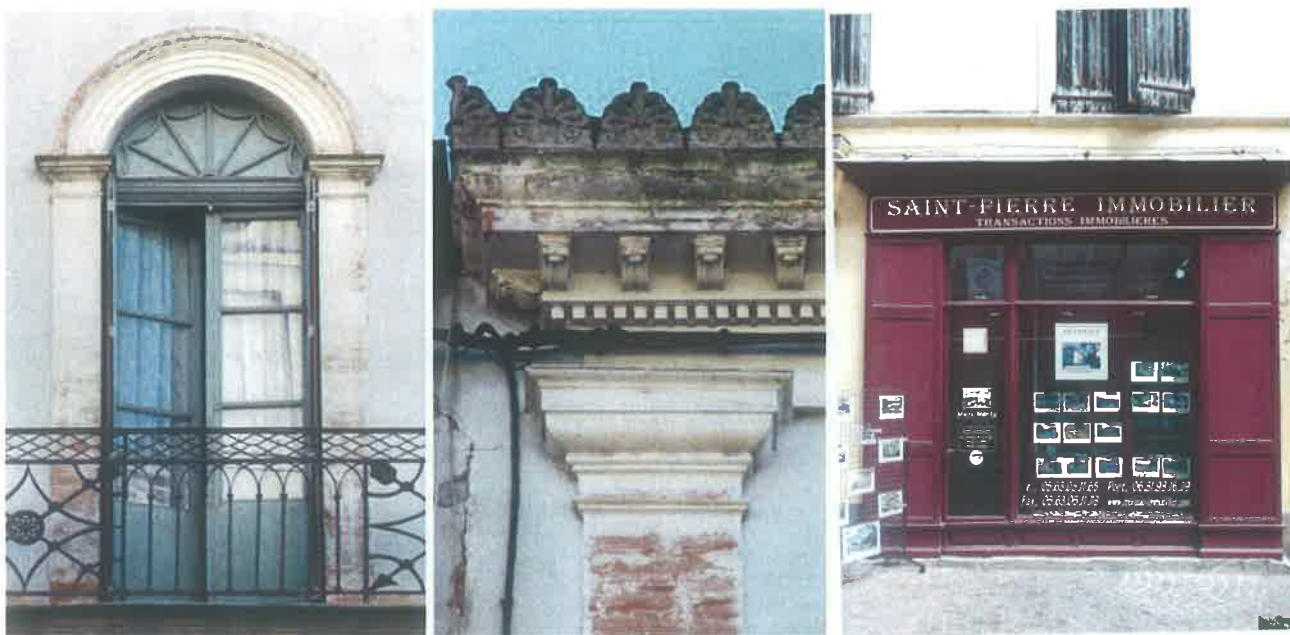
Détails d'architectures des XVIII e et XIX e siècles: balcons ouvragés, détails de baies et décors architecturés des façades, corniches et pilastres en briques enduites et badigeonnées à l'imitation de la pierre, devantures menuisées des boutiques.
