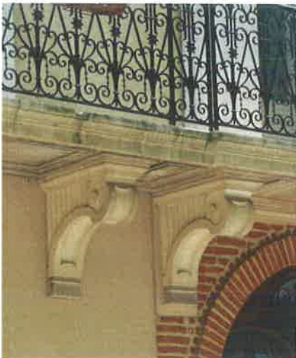
17, Allée Marengo. Balcon en surplomb sur corniches, garde corps fer forgé. XIX e siècle.
