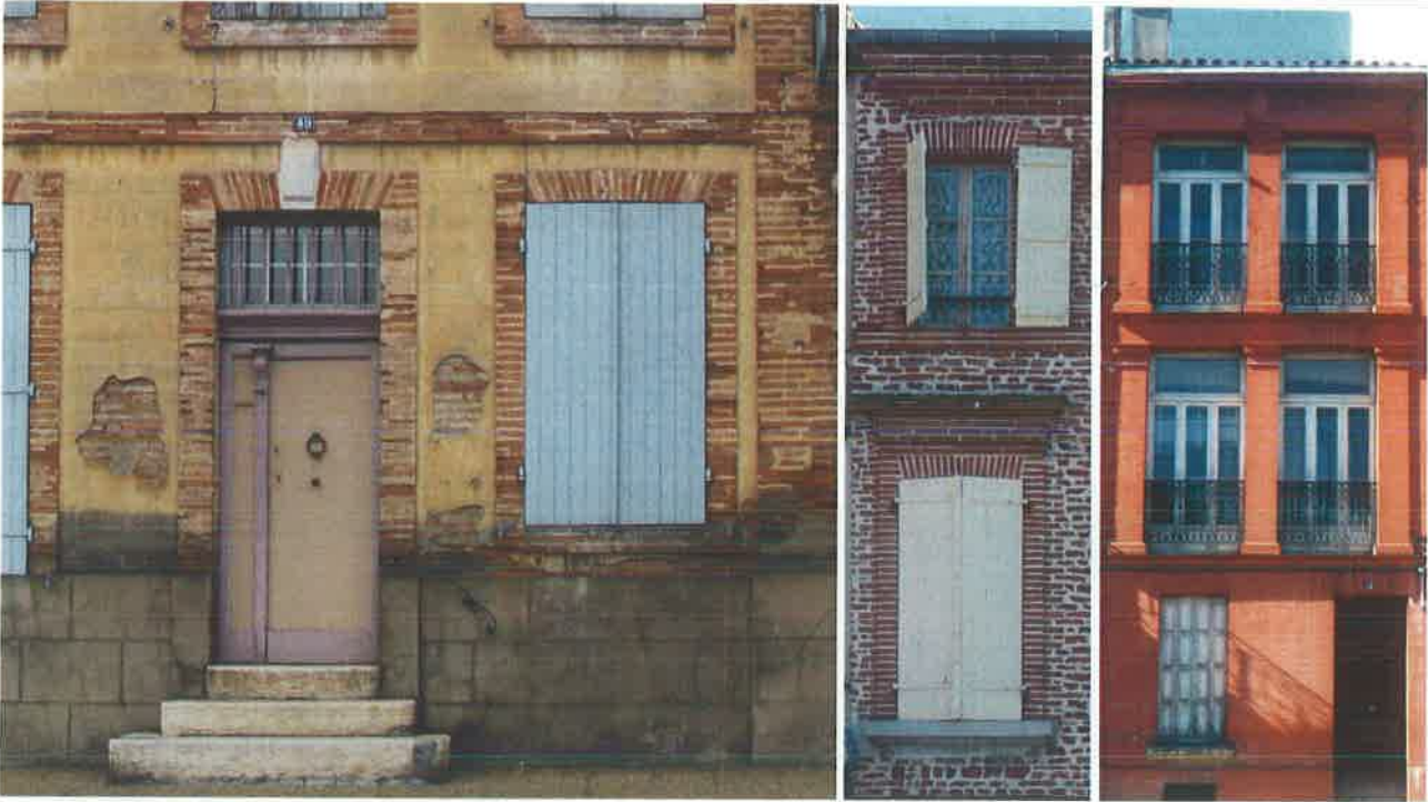
Maison du Boulevard Alsace Lorraine. Soubassement en faux appareil de pierre tracé sur enduit et perron empiétant sur l'espace public. Façades et détails des maisons du Boulevard Alsace-Lorraine.
