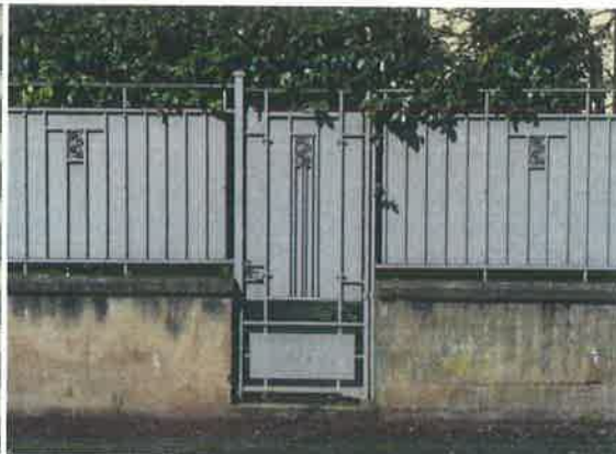
Rue du Maroc. Clôture, mur bahut panneaux et grilles métalliques.
