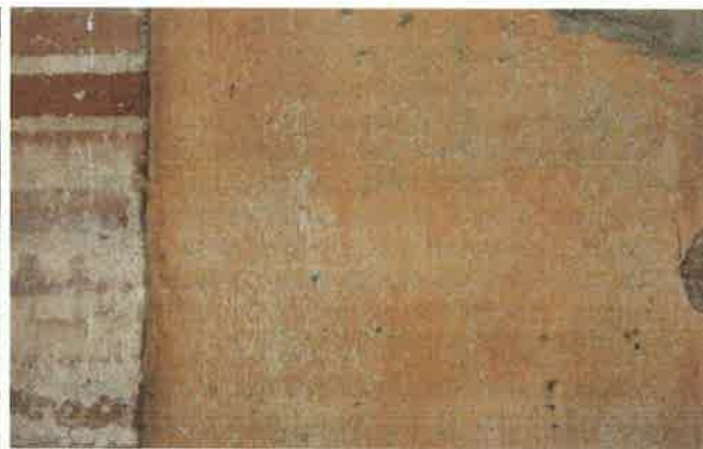
Enduit de chaux et badigeon d'ocres.
