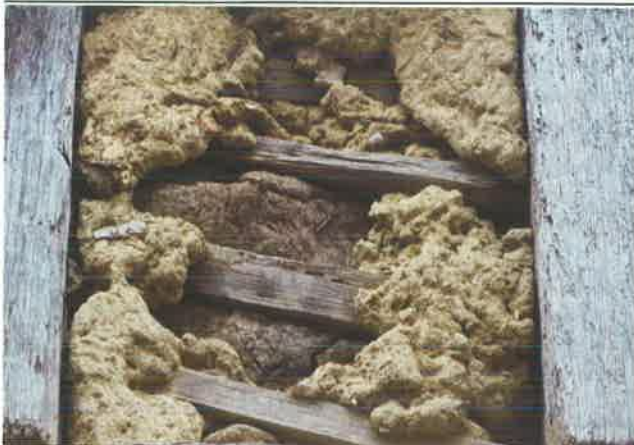
Pans de bois et torchis dégradé et vestiges d'enduit de protection à la chaux sur torchis. Ces maçonneries anciennes présentent de grandes qualités mais sont fragilisées par le non entretien des enduits.
