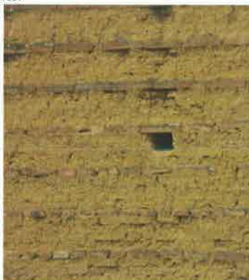
Pans de bois et torchis dégradé et vestiges d'enduit de protection à la chaux sur torchis. Ces maçonneries anciennes présentent de grandes qualités mais sont fragilisées par le non entretien des enduits.
