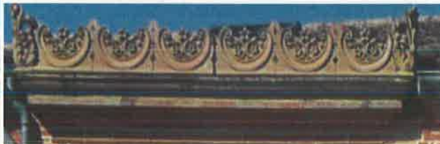
Corniches de briques et acrotères de terre cuite.
