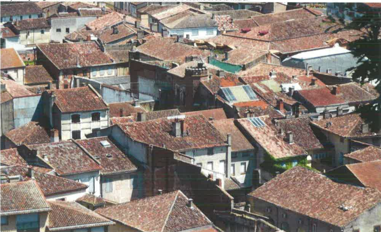
Le paysage des toits de Moissac : l'ocre brun des tuiles de terre cuite, les ondulations des tuiles canal, les prises de jour et les quelques verrières forment un paysage homogène avec une valeur d'ensemble. les verrières des prises de jour et les lucarnes sur les pentures ou dans les brisis.
