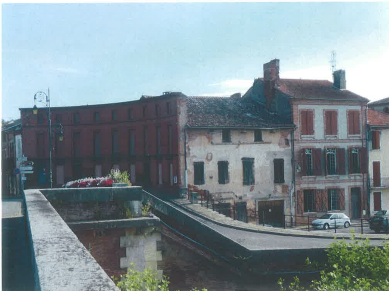
Les façades ordonnancées et symétriques de l'hémicycle magnifient l'entrée de ville. Détail du collage des façades décoratives. Certaines ouvertures sur le bâtiment Est restent aveugles.
