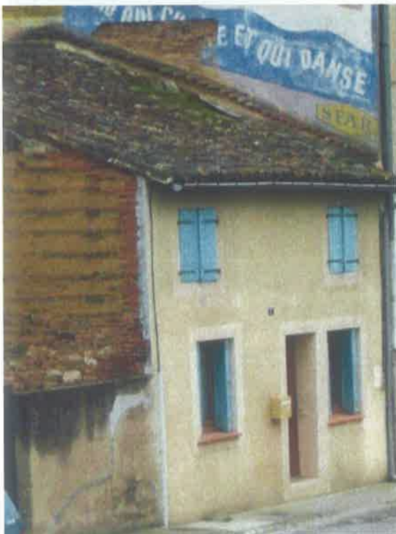
Petite maison de faubourg . Mur latéral en lits alternés de briques cuites et crues. Quai Ducos.
