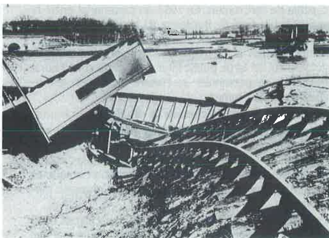
Le pont ferroviaire après la grande crue.
