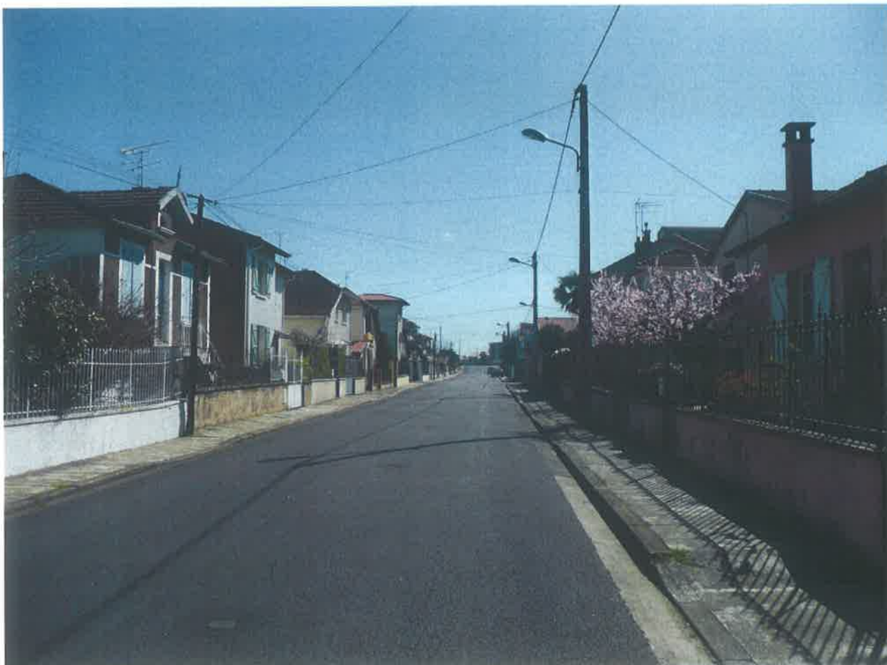
Les maisons reconstruites en ordre discontinu rue du Maroc.
