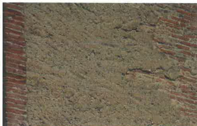
Vestiges d'enduit chaux, terre et sable, place du vieux port.
