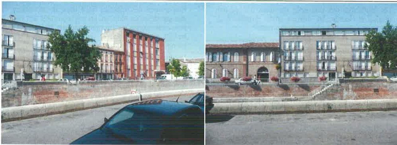
Démolition de bâtis anciens et reconstruction en rupture de gabarit.
