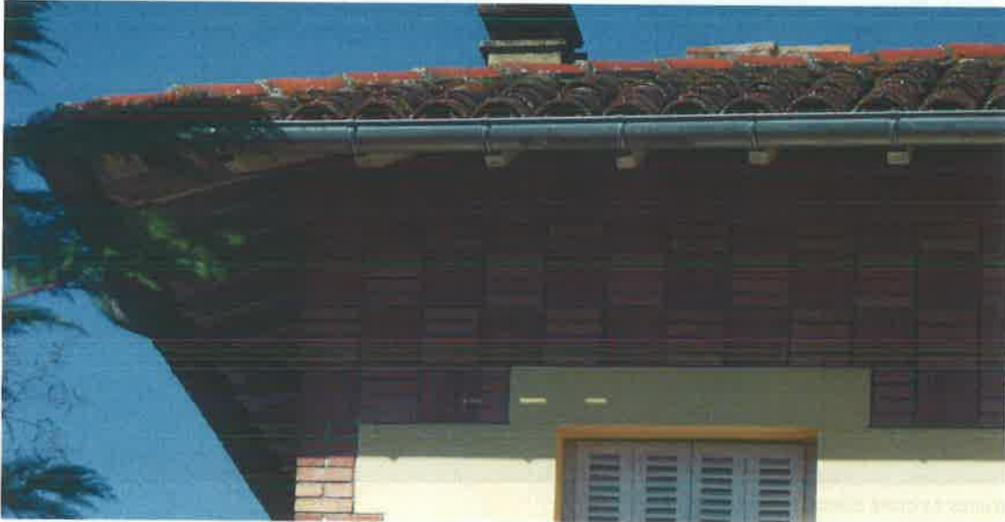
Rue du Maroc. Décor de briques, polychromie et calepinage.
