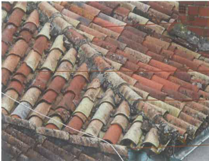
Egout avec tuile canal en courant et débord
