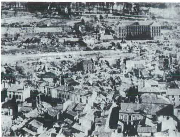
Vue générale de Moissac après la crue du 03 mars 1930.
