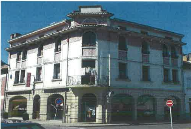
Maison rue du Général Gras. Années 1930-1940.
