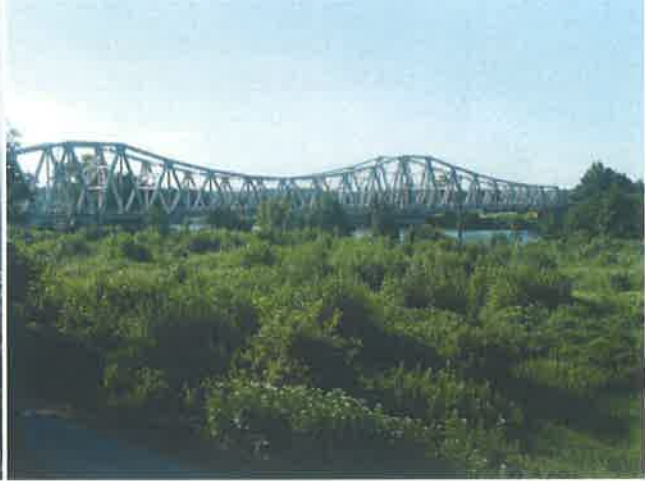
La voie de chemin de fer et les infrastructures de franchissement du Tarn.
