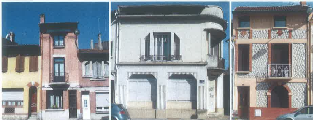
Maisons du Boulevard du Général Gras. Fenêtres larges, balcons et ferronnerie, décors stylisés et utilisation en ornementation, opus incertum de fausses pierres. . Au centre, maison du centre l'angle à pan coupé est traité dans un style proche de l'entrée monumentale du Grand Hôtel.
