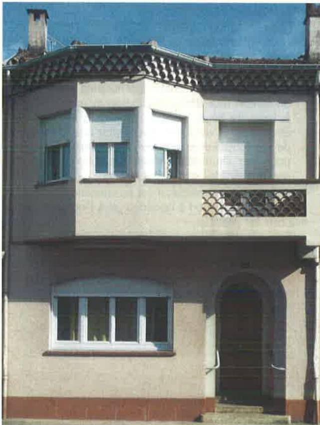
Années 1930 construction en béton ciment.
