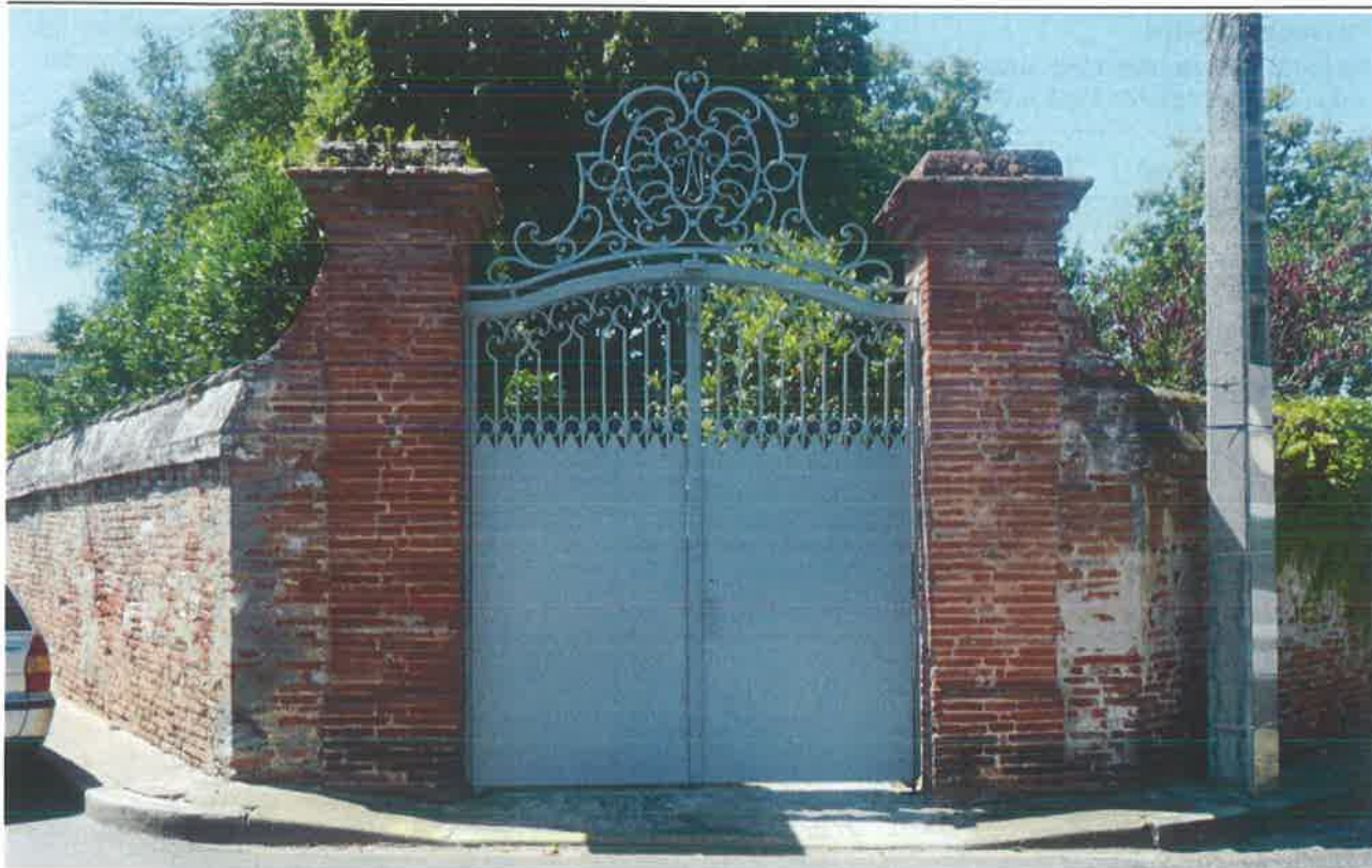
Portail de jardin monumentalisé, finesse des détails de ferronnerie, vestiges d'enduit sur les murs. Rue Raynal.
