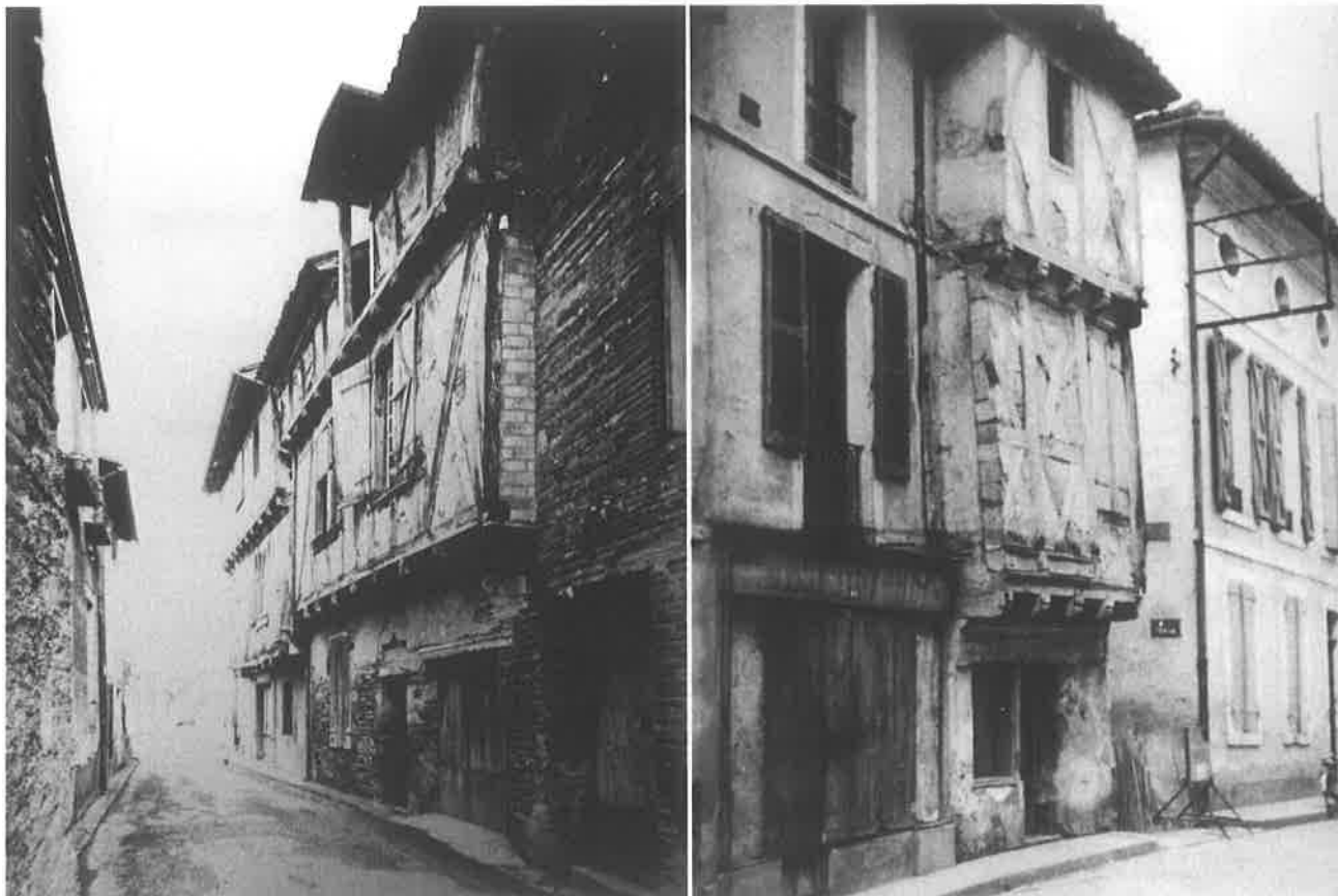
Vues anciennes de maisons à pan de bois . A.M. Moissac .
