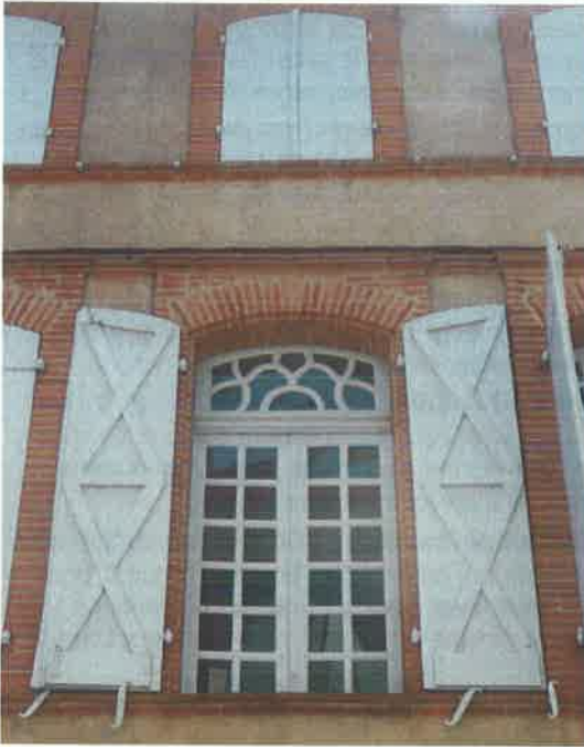
Les contrevents permettent de faire obstacle à l'air froid en hiver et aux excès du rayonnement solaire estival.
