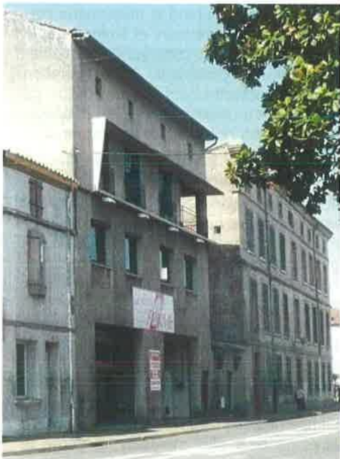
Restauration ne respectant pas les éléments régulateurs de la façade.
