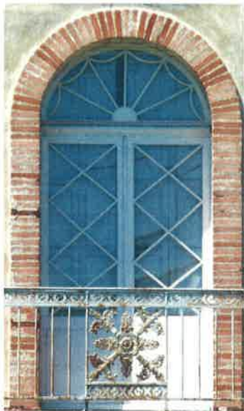
La porte fenêtre sur balcon. Partition en losanges de l'imposte et des petits bois.
