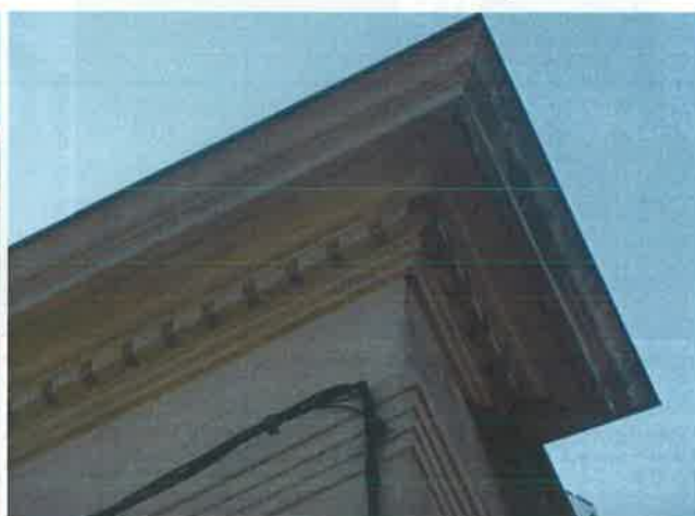
Corniche brique enduite et motifs de denticule courant sur la façade principale.
