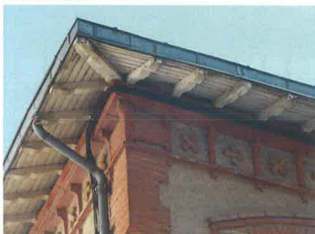
Frise décorative couronnant le mur, passe toit en coffre de planches.
