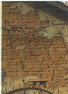
Pans de bois et torchis dégradé et vestiges d'enduit de protection à la chaux sur torchis. Ces maçonneries anciennes présentent de grandes qualités mais sont fragilisées par le non entretien des enduits.
