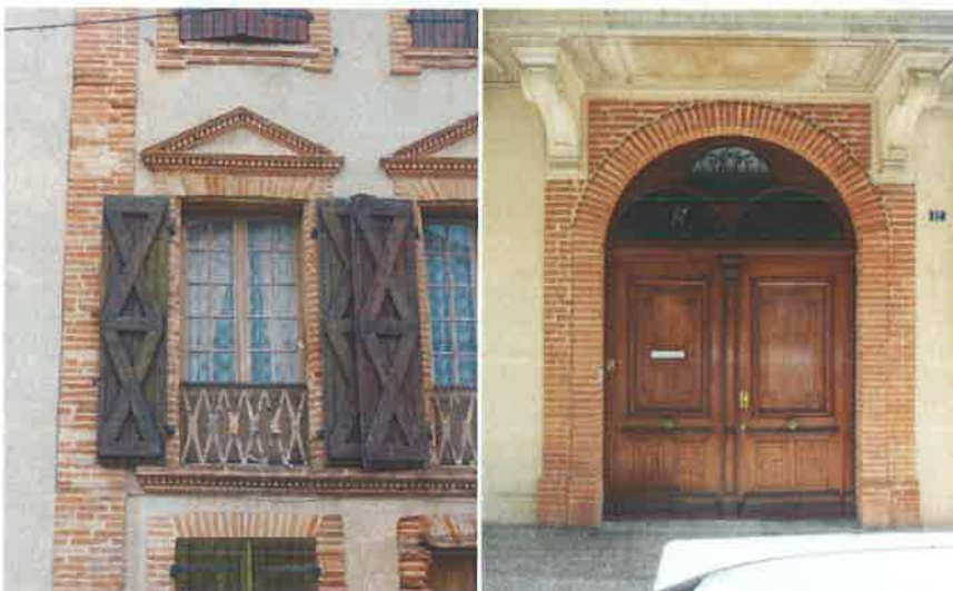
Détails d'architecture , portes fenêtres, contrevents bd. Delthil Allées Marengo.
