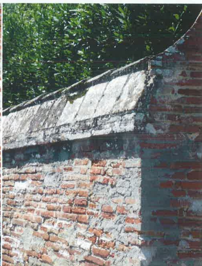
Mur de clôture, détail du chaperon réalisé en briques plates et tuiles canal. Rue Raynal.
