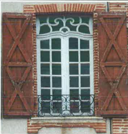
Fenêtre type XVIII e . Contrevents à planches barres en croix de St. André. Partition des croisillons et petits bois en petits carreaux, décor de l'imposte.
