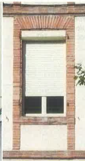
Coffre de volet roulant en saillie sur la façade.
