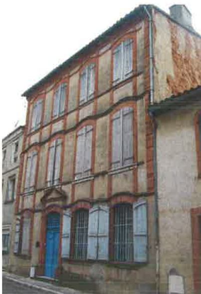
29, rue Lagrèse-Fossat. Symétrie axée des travées.
