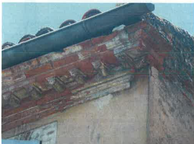
Corniche brique et métopes en terres cuites courant sur la façade principale.
