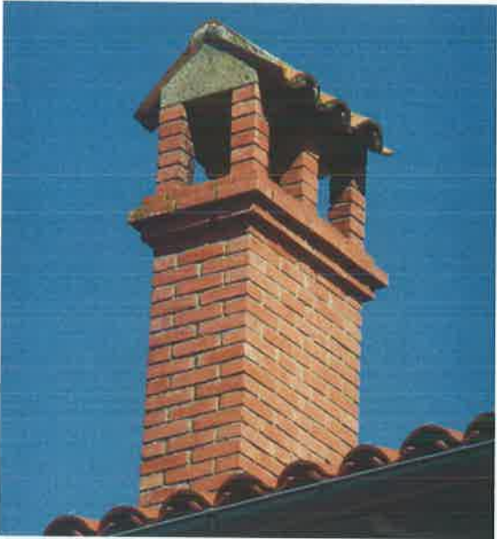
Rue du Maroc. Cheminée et sa mitre.
